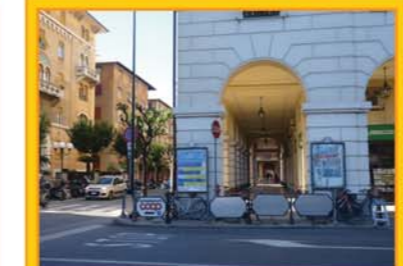
Piazza della Stazione
